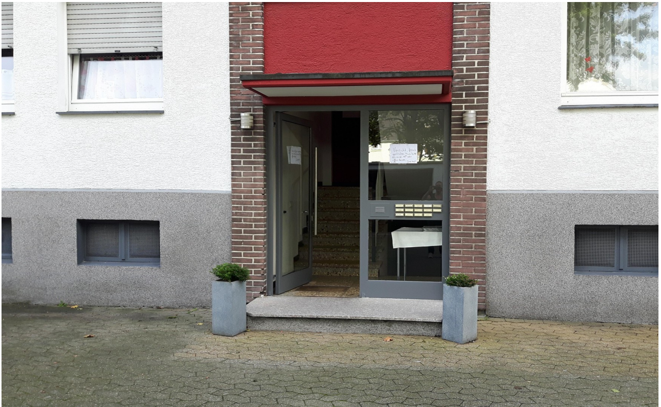
Hauseingang im Hof
