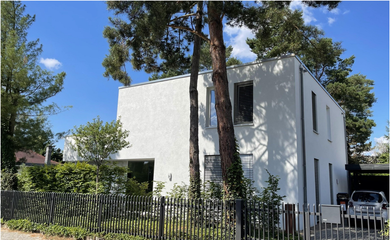
Außenansicht von der Straße
