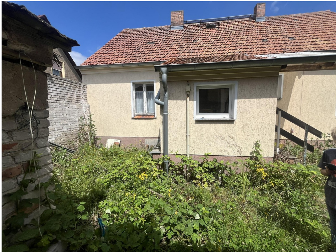
hofseitige Ansicht Wohnhaus
