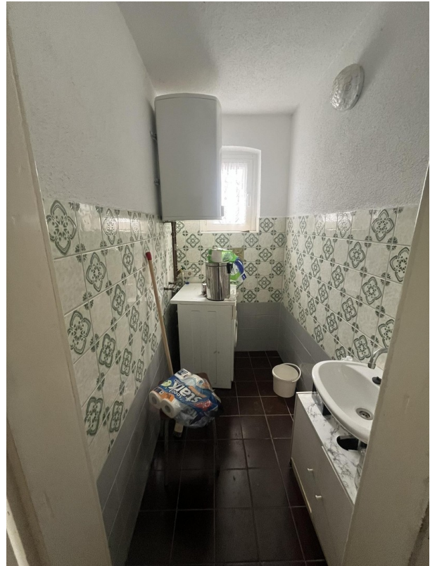
Hauswirtschaftsraum mit Boiler
