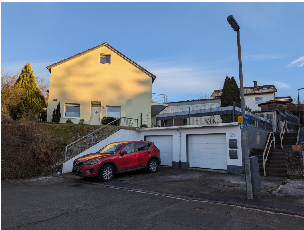
Haus von der Straße aus
