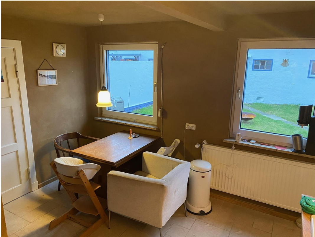
Küche mit Lehmputz
