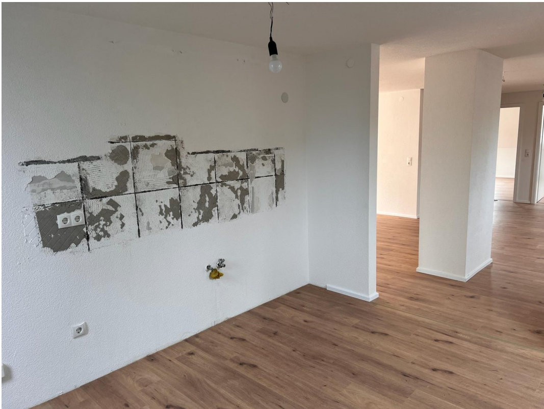
Küche (vor Installation)
