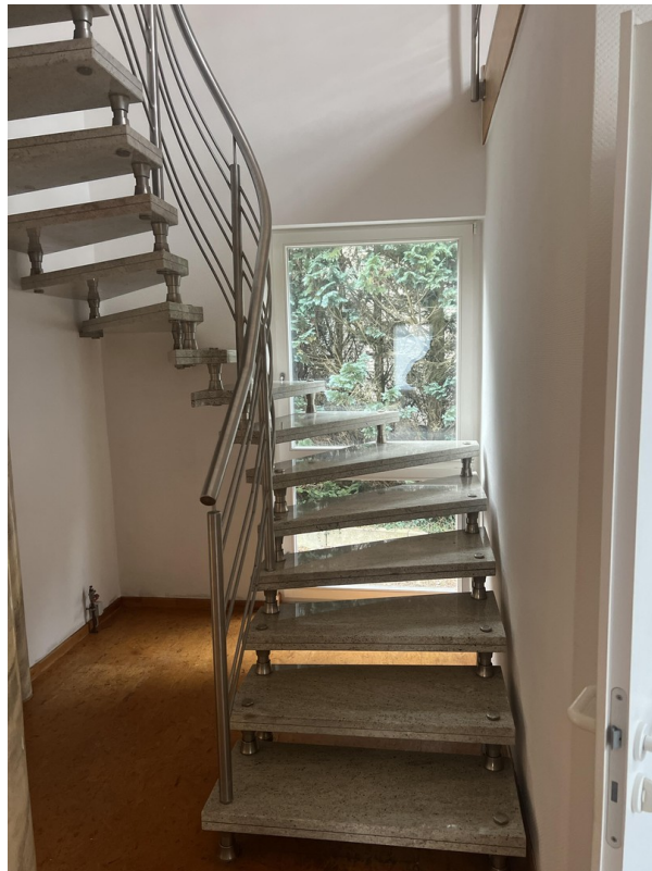
Treppe ins OG
