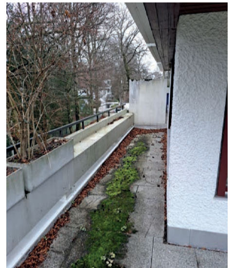
Balkon Wohnzimmer seitlich nach Westen
