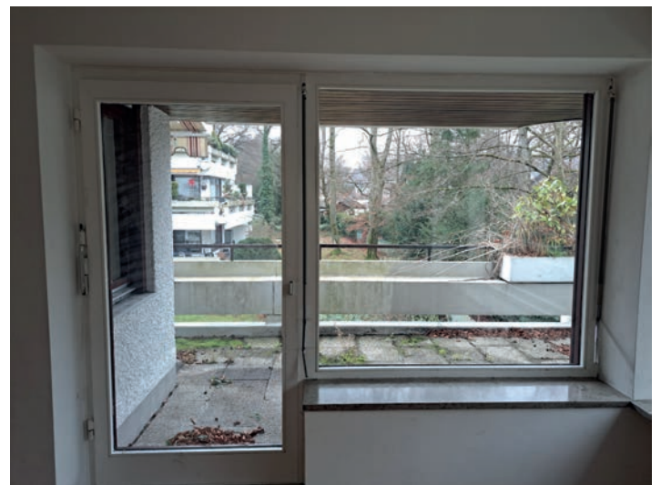
Blick auf überdachten Balkonbereich
