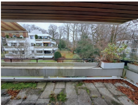
Balkon überdacht vor Wohnzimmer
