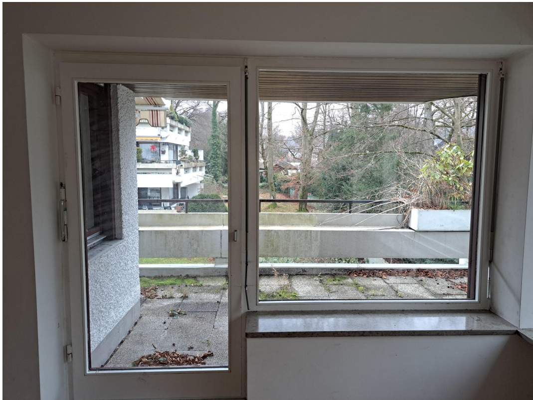
Blick auf überdachten Balkon
