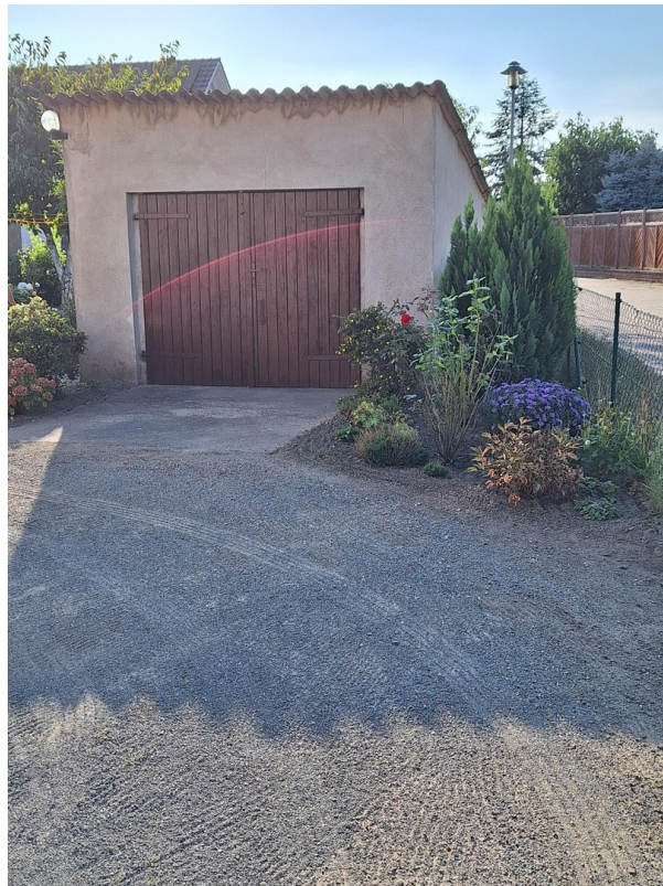
Garage mit Zufahrt
