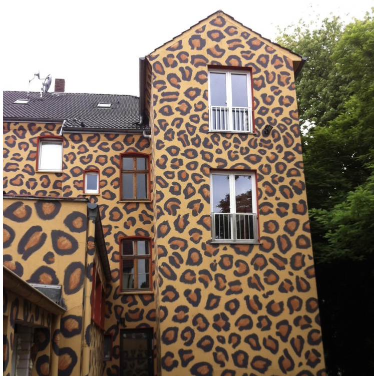
Eingang vom Hof
