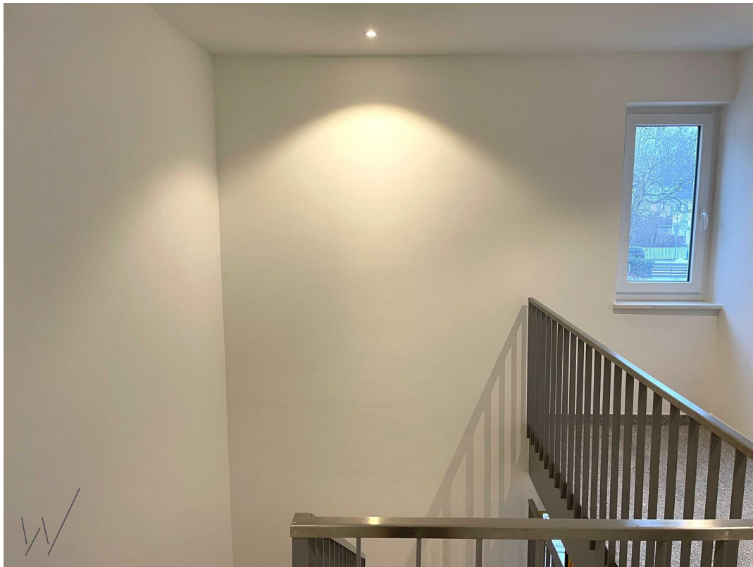
Treppenhaus mit Fenster
