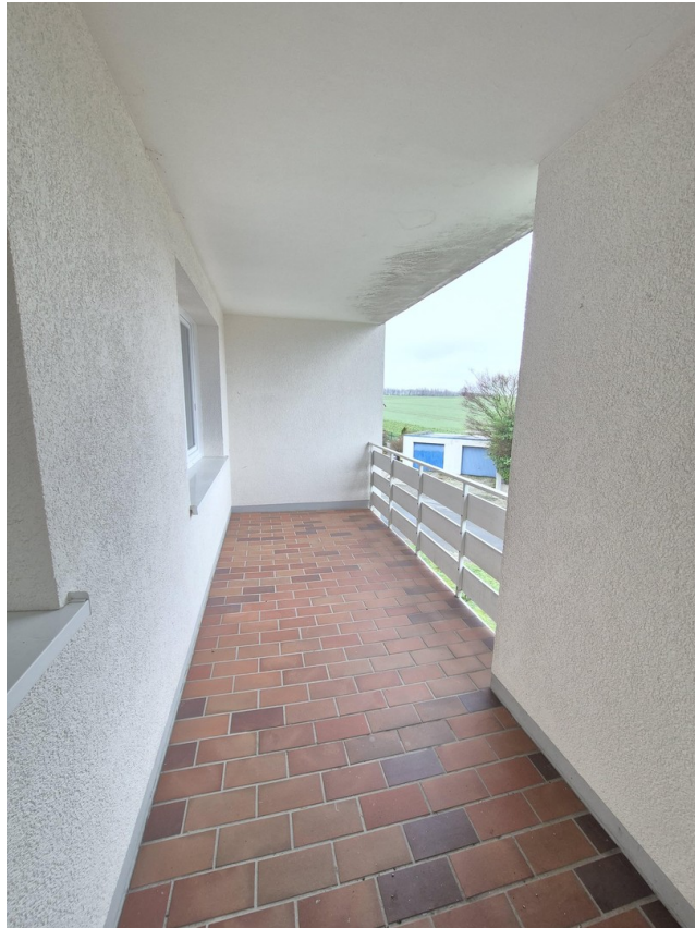
Balkon mit Blick auf Felder
