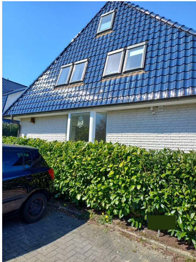
Außenansicht vom Parkplatz
