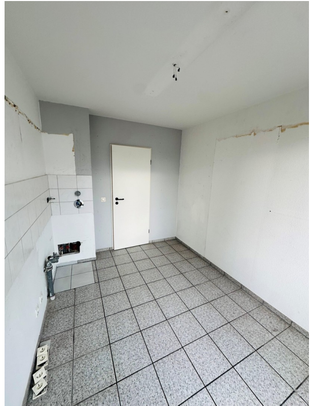
Küche aktuell / nicht Saniert
