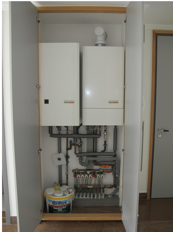
Gas-Brennwertheizung
