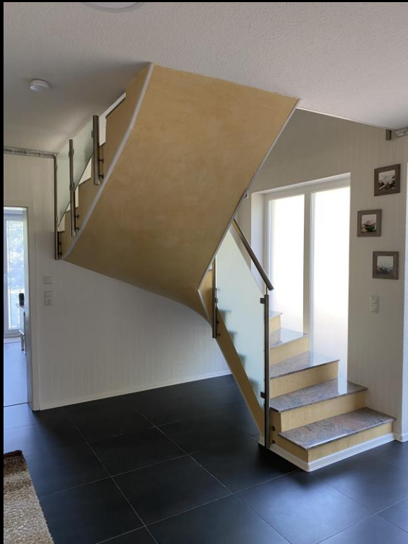
Innentreppe EG zu OG Massiv Beton
