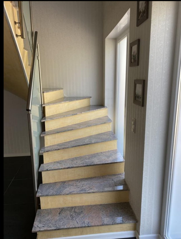
Innentreppe EG zu OG Granit - Stuccoputz
