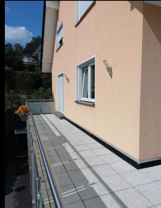
Ansicht Balkon UG Westseite
