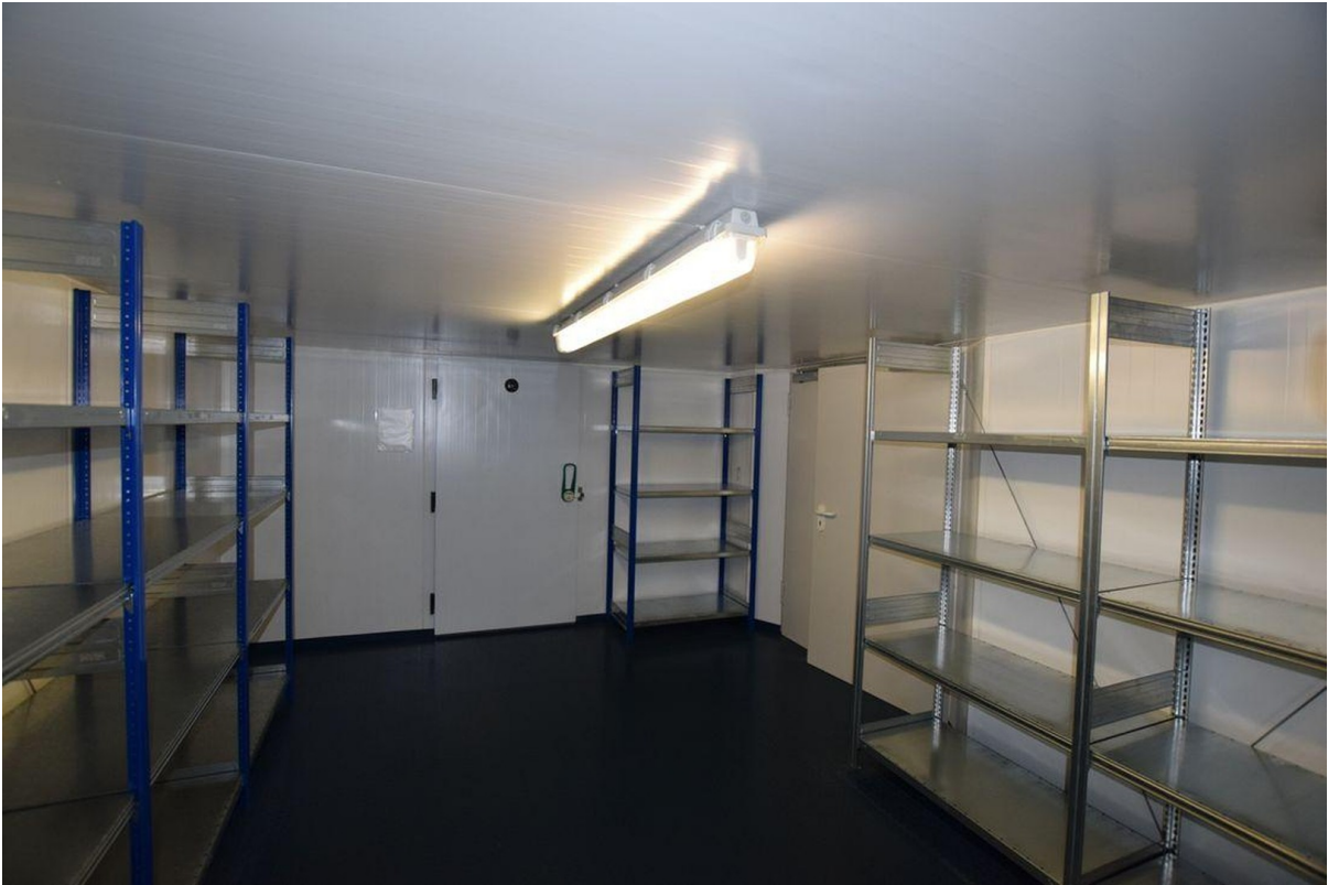
Kühlraum (im UG)
