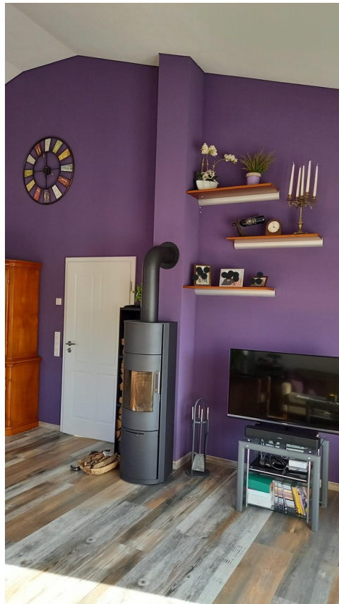
Kaminofen im Wohnbereich
