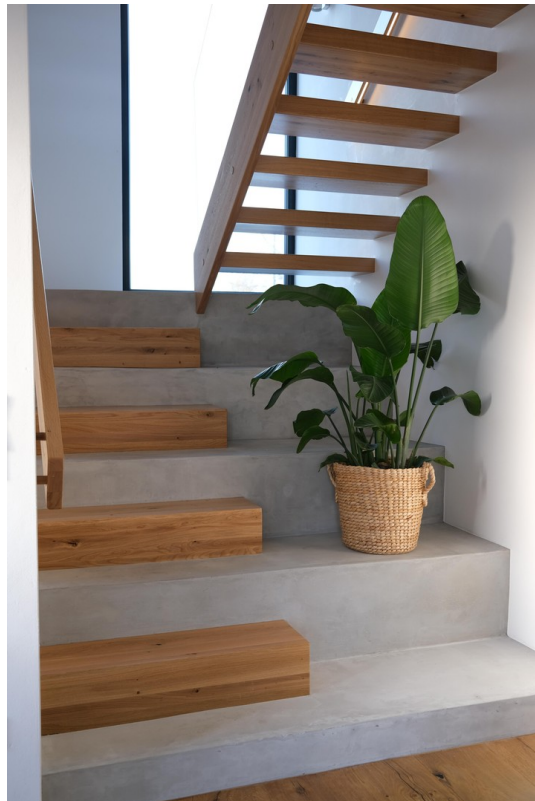
Treppe im EG
