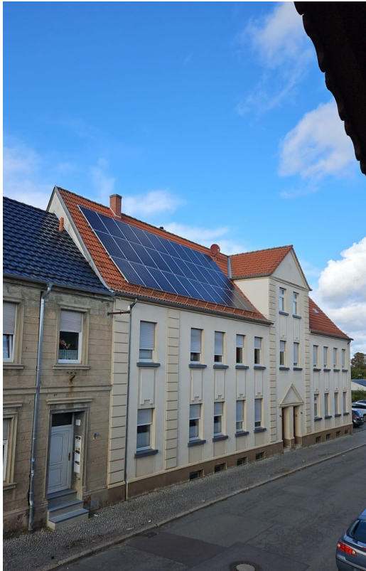
Frontansicht mit Solaranlage
