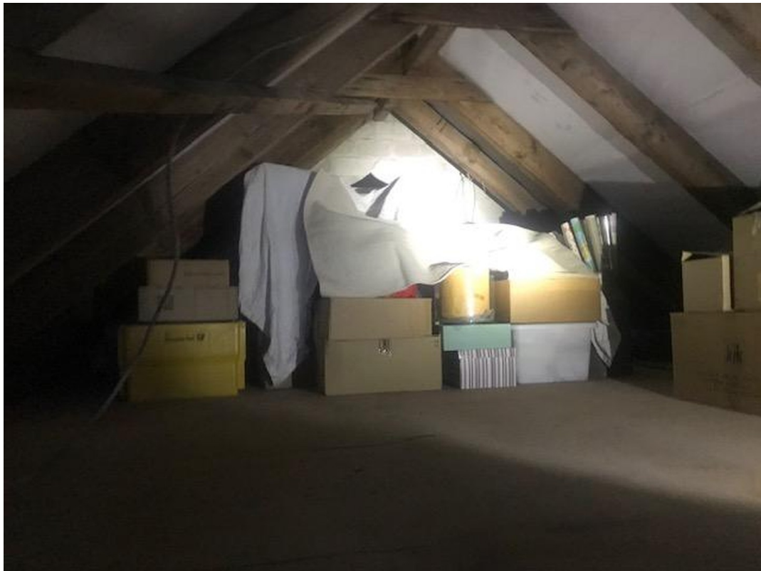
Spitzboden im Dach
