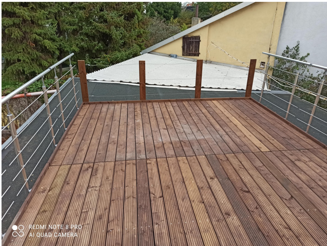
Dachterrasse am Anbau
