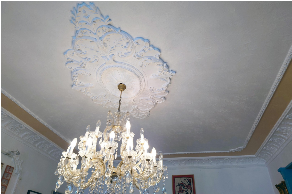
Decke mit Stuck und Leuchter
