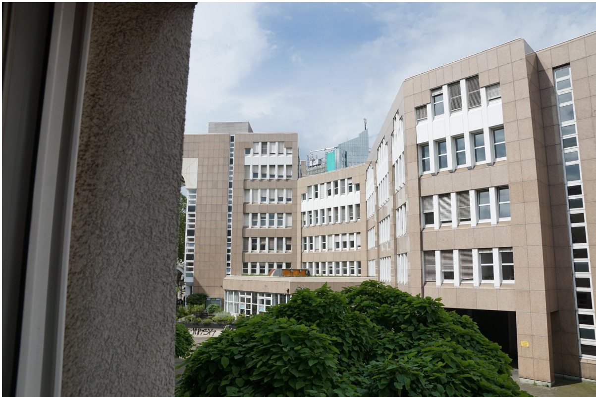
Blick in Fußgängerzone links
