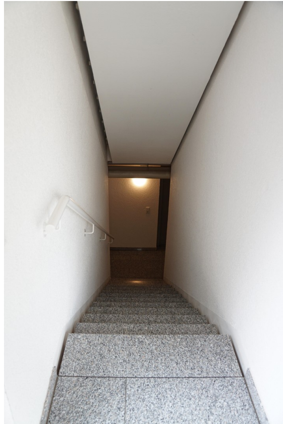
Treppenabgang in UG1 und UG2
