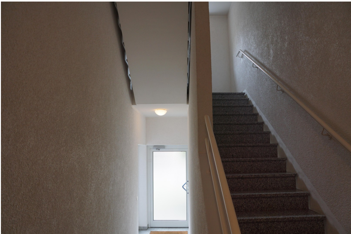
Treppenhaus von Aufzug in EG
