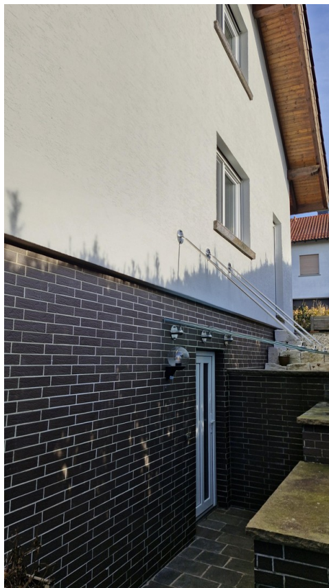
Nebeneingang zum Untergeschoss
