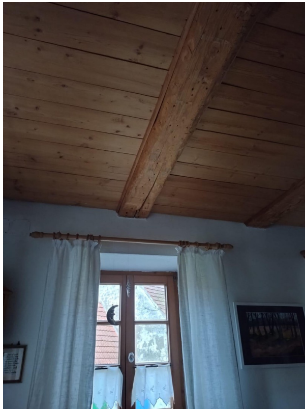
Balkendecke in der Küche
