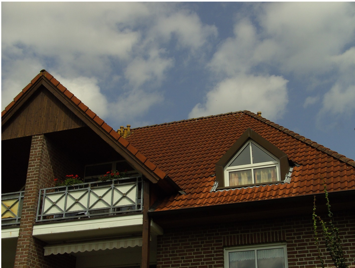
Loggia und Dachgaube Essecke
