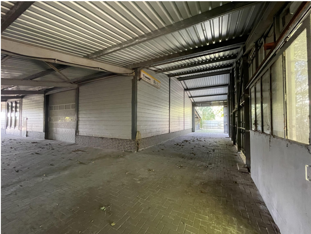
Halle Überdachung hinten
