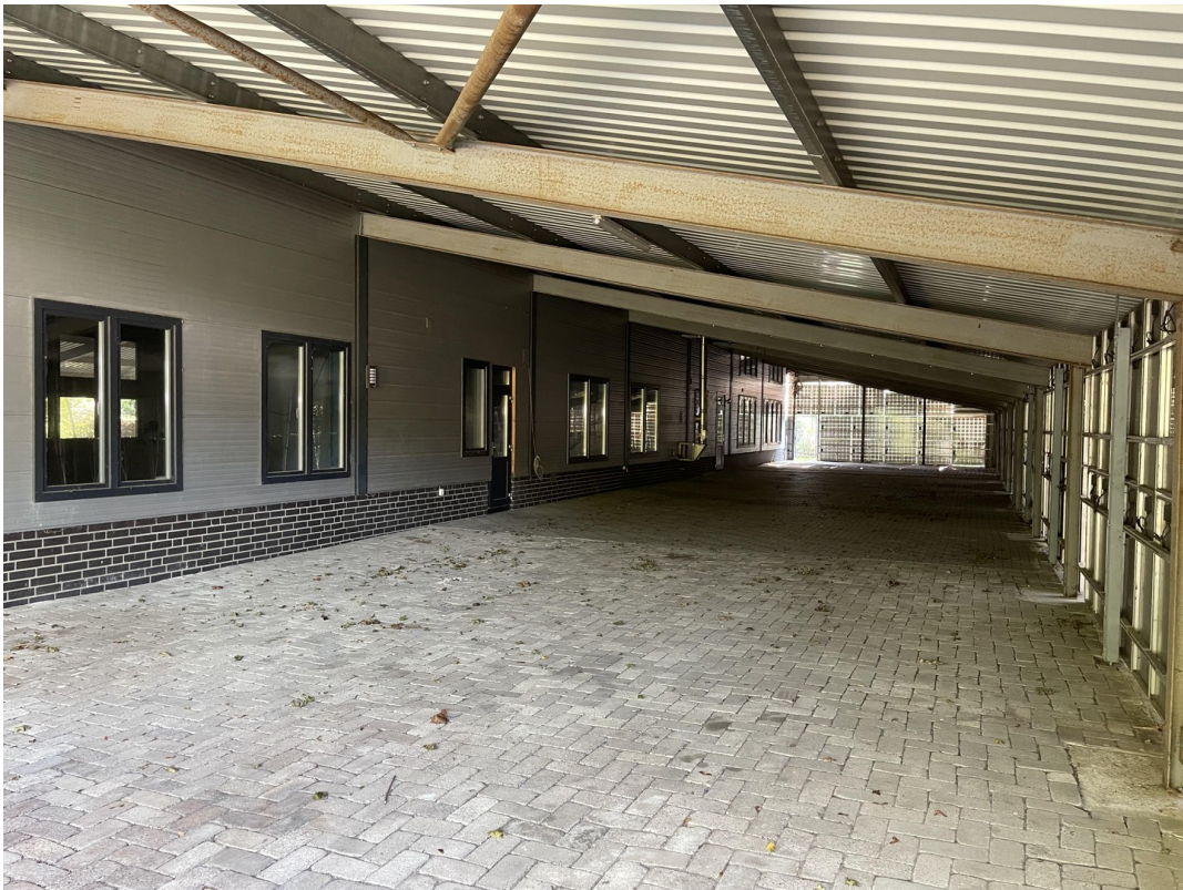
Halle Überdachung links
