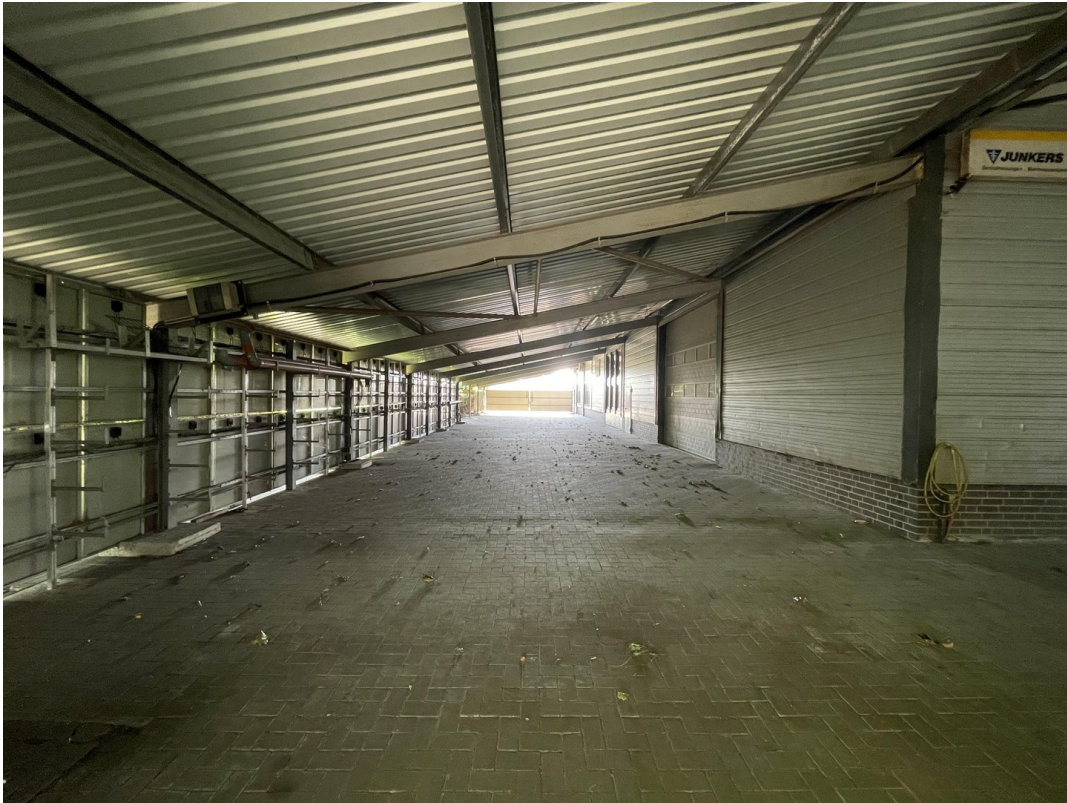
Halle Überdachung rechts
