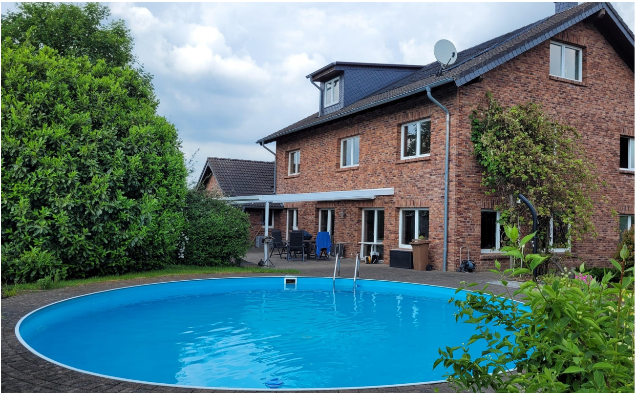
Rückseite, Pool und Terrasse
