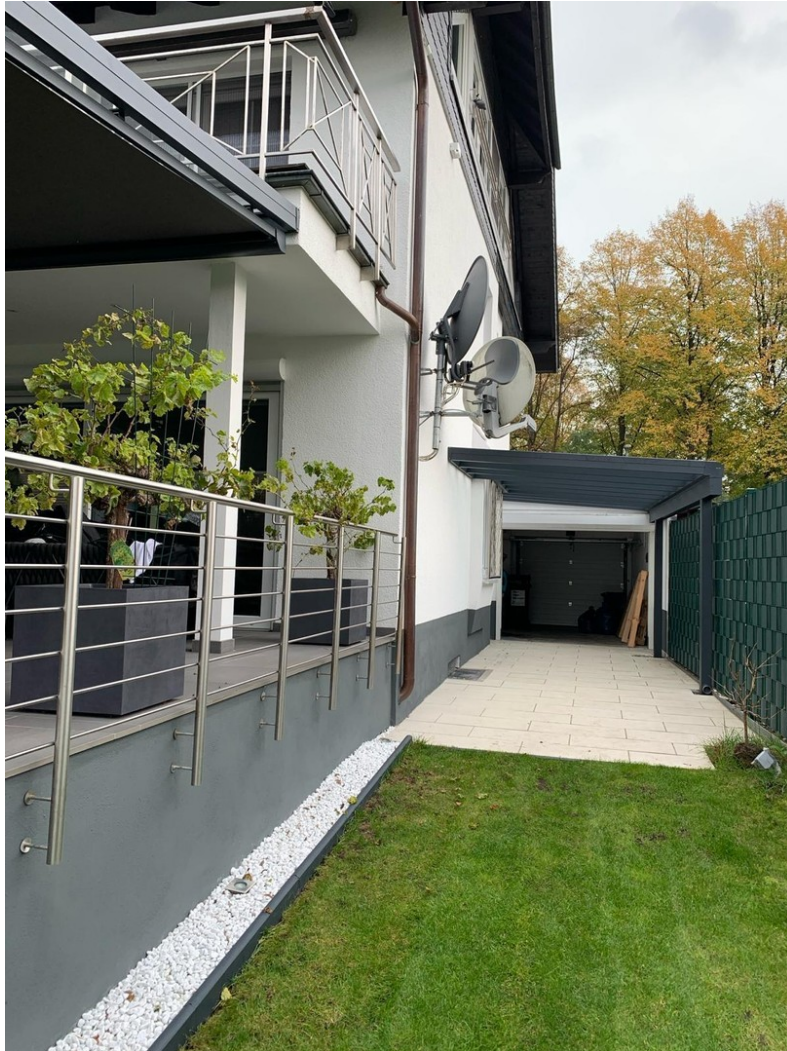
Zugang Garage zum Garten
