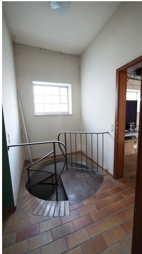
EG Treppe in Keller
