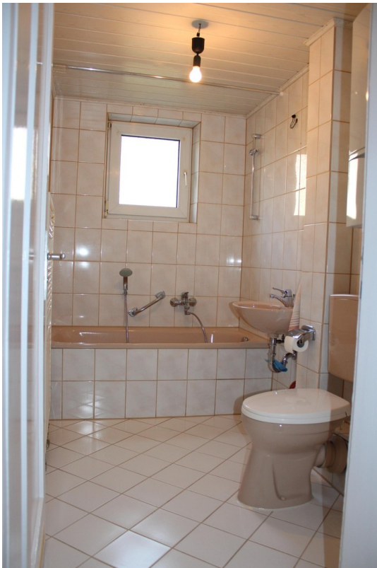
Tageslichtbad mit Dusche/WC
