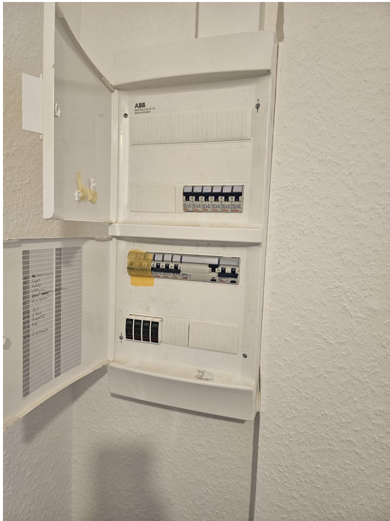
neue Elektrounterverteilung
