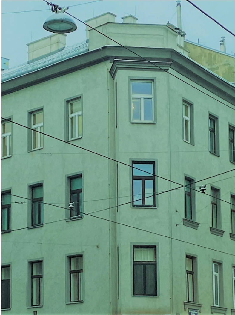
Altbauhaus vor Fertigstellung
