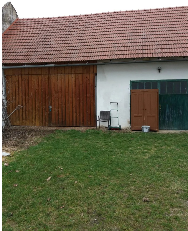
Scheune mit Garage
