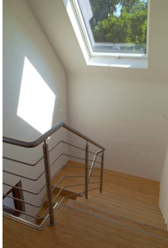
Treppe mit neuem Dachflächenfenster
