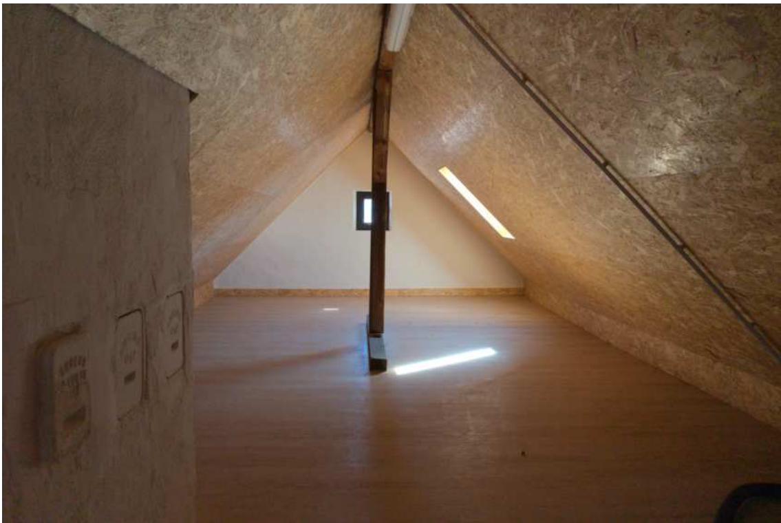
Ausgebauter und gedämmter Spitzboden
