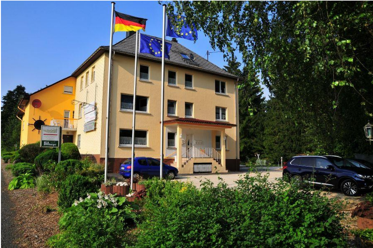
Hauptgebäude von West
