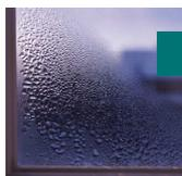
Veraltete Abstandhalter aus Aluminium sind stark wärmeleitend und führen oft zu Kondenswasser in Rahmennähe. Zeitgemäße Abstandhalter, oft als »warme Kante« bezeichnet, werden aus geeigneteren Materialien gefertigt und verbessern den U-Wert des Fensters um ca. 10 %.
